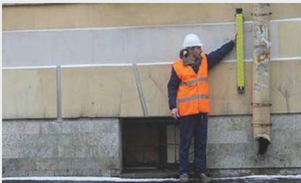
Геодезический мониторинг наблюдения за деформациями зданий и сооружений
